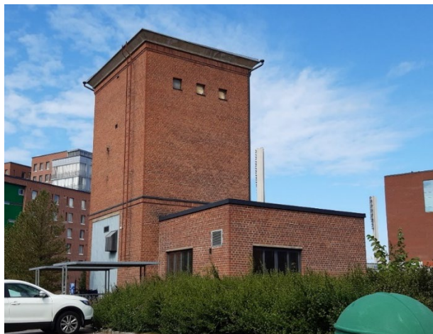
Kuva 5: Muuntamotorni ja laajennusosa.
