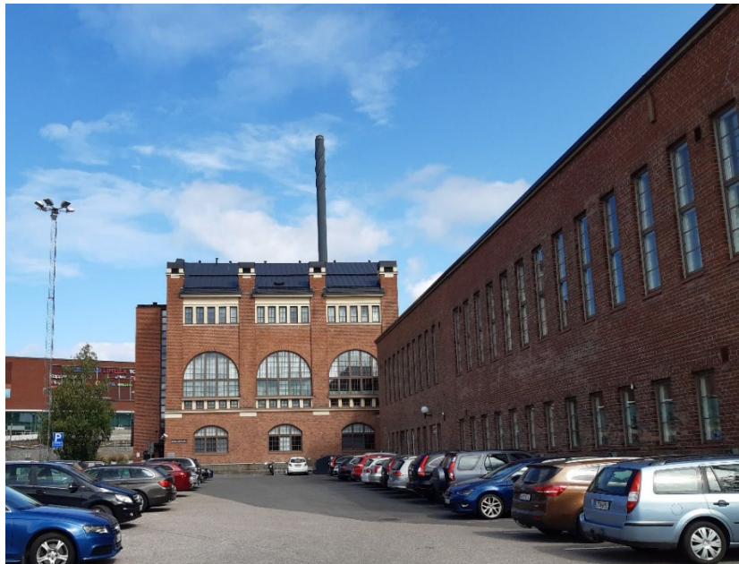
Kuva 4: Entisen höyryvoima-aseman punatiilinen julkisivu komeine kaari-ikkunoineen sekä myöhemmin rakennettu laajennusosa.
